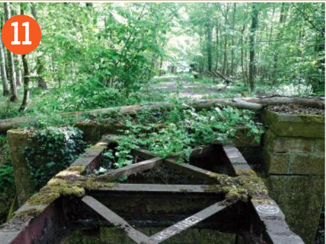
11 Tramschiene – Ichner Wald Die Tramschienen entsprechen der ehemaligen Bahntrasse der Schmalspureisenbahn "Entenkörper" zwischen Kehl - Ottenheim - Seelbach. Die Bahn war von 1894 bis 1959 in Betrieb.
