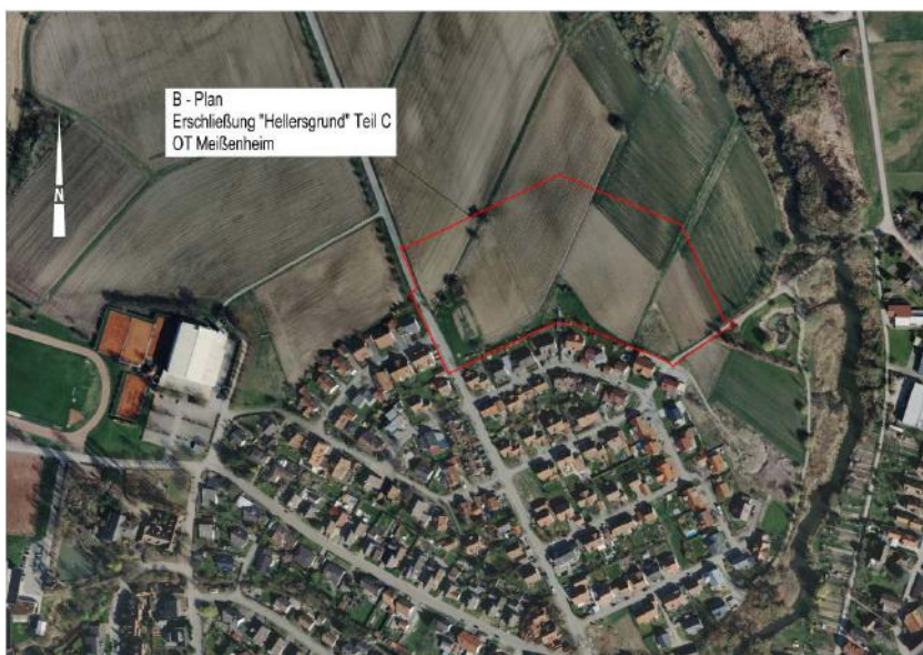
Abbildung 1: Übersicht Luftbild Erschließung „Hellersgrund“ Teil C in Meißenheim
